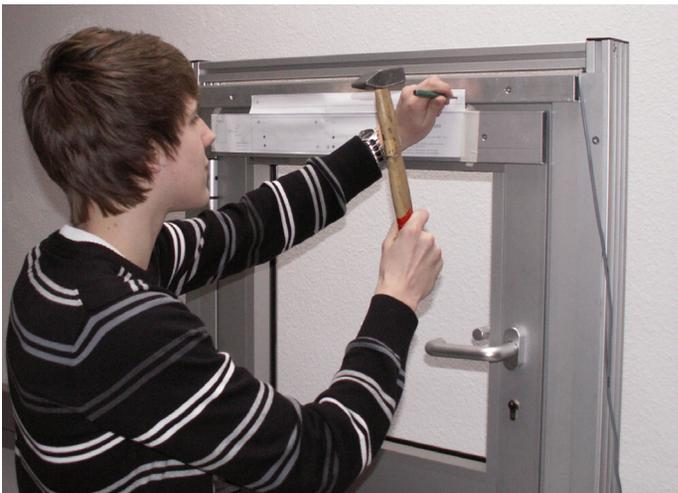
Die Position der einzusetzenden Gewindehülsen wird markiert.
