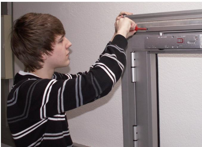
Darauf wird nun der Türschließer montiert.
