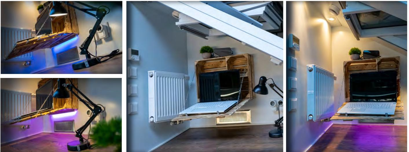
Das Arbeitszimmer stellt den Raum mit einer Dachschräge dar und ist praxisgetreu mit einem Velux-Dachfenster, inklusive einer Elektro-Hitzeschutz-Markise, ausgestattet. Beides ist in das digitale Gebäudesystem eingebunden. Die Beheizung des Raumes erfolgt mittels eines funktionsfähig angeschlossenen Heizkörpers mit Stellantrieb.
