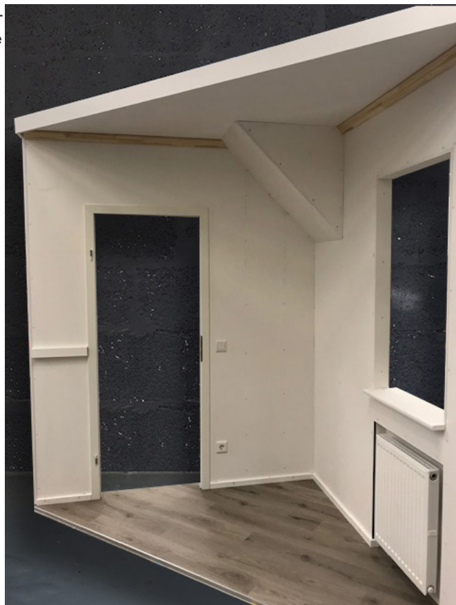
Kabine mit Türöffnung Standard, Fensterleibung, Heizkörper, Dachgaube, Fußleiste, Stuck, Kabelkanal, Steckdose und Fallrohr
