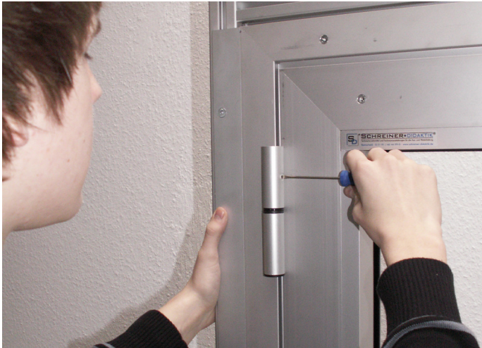
Die Tür ist mit einstellbaren Türbändern ausgestattet.
