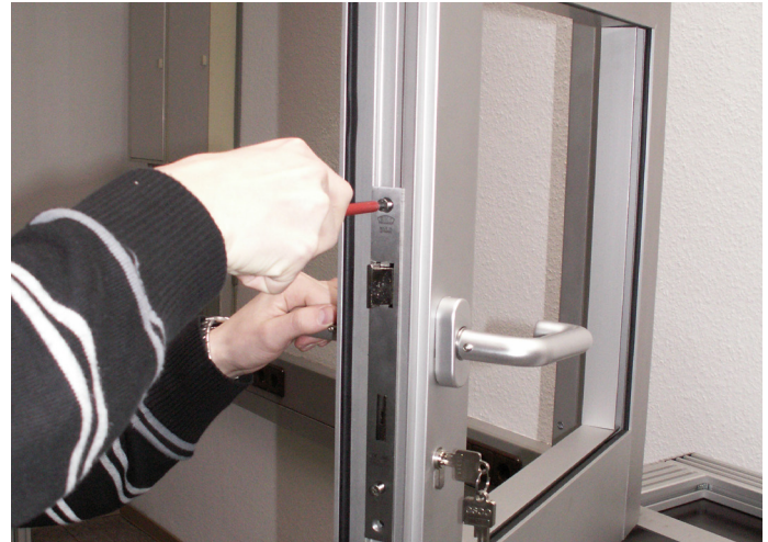
Die Drückergarnitur kann aus- und eingebaut werden...
